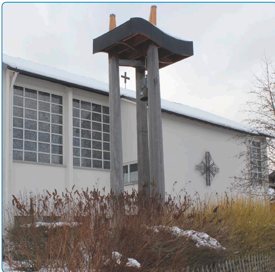
Bildhauer Thomas Matt bearbeitet die Holzstützen des Glockenturms. Mit der Kettensäge bringt er die Douglasienstämme in Form. FOTO: WEISE
